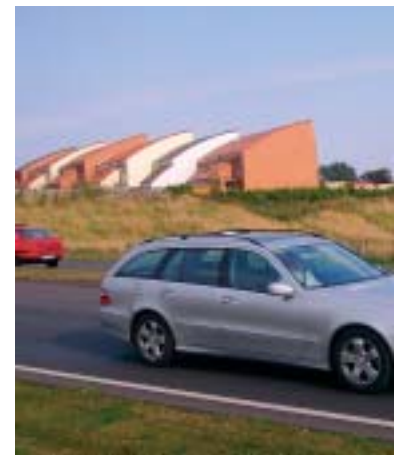
Gebäuderiegel Hang Alt Bartelsdorf
