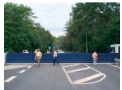
Sturmflutschutztor an der Zufahrt zum Wohngebiet Tonnenhof
