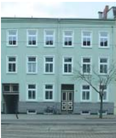
Mit Unterstützung des Schallschutzfensterprogrammes lärm-saniertes Wohngebäude in der Rostocker Innenstadt
