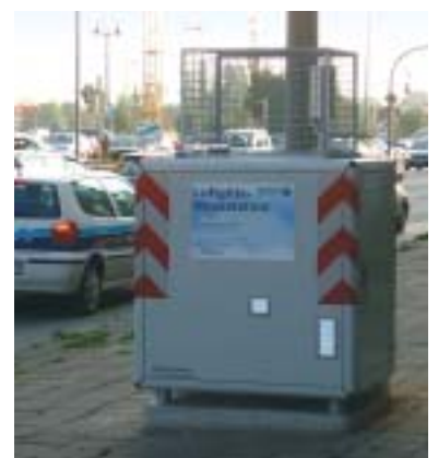
Messstation „Am Strande“
