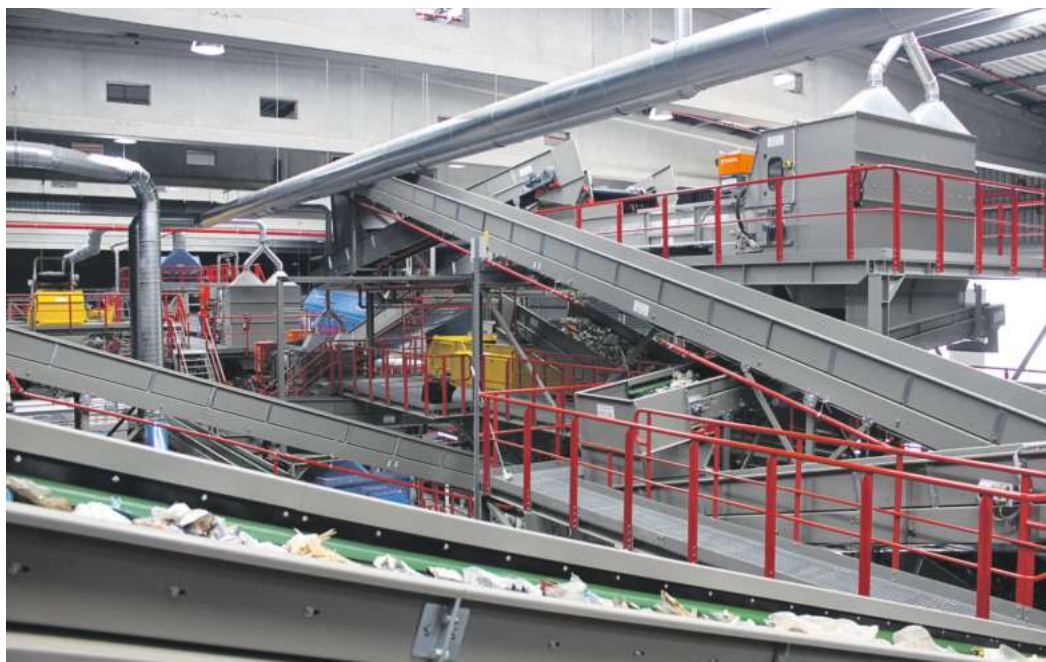
Sortieranlage für Verkaufsverpackungsabfälle der Veolia Umweltservice Nord GmbH
