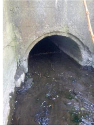
**Zustand:** Betonbauwerk mit Rohrdurchlass DN 800 und vorgesetzten Flügeln, brüchig
