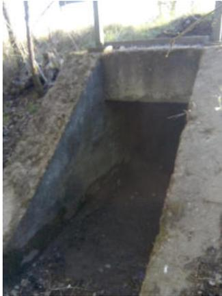
**Zustand:** Betonbauwerk mit Plattendurchlass ca. 1\*1,1m, brüchig
