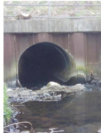
**Zustand:** Betonbauwerk mit Rohrdurchlass ca. DN 1200 und Stahlwand im Einlaufbereich, weitestgehend guter Sichtzustand
