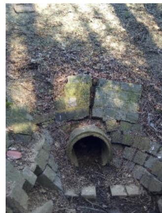
**Abfluss:** über Betonbauwerk, Weiterführung über trockenen Graben zu kleinerer Verrohrung
