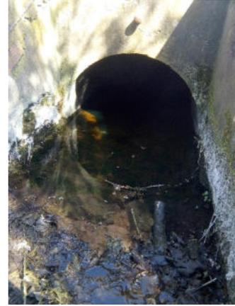
**Zustand:** Betonbauwerk mit Rohrdurchlass DN 1000 und vorgesetzten Flügeln, brüchig
