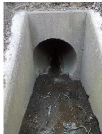
**Zustand:** Betonbauwerk mit Rohrdurchlass DN 1000 und vorgesetzten Flügeln, guter Sichtzustand, Randbereiche brüchig
