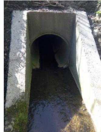
**Zustand:** Betonbauwerk mit Rohrdurchlass DN 1000 und vorgesetzten Flügeln, guter Sichtzustand
