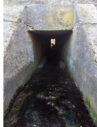
**Zustand:** Betonbauwerk mit Plattendurchlass 1\*1,1m und vorgesetzten Flügeln, brüchig
