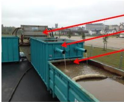
Verteilerbauwerk mit 1. Ölabscheider
