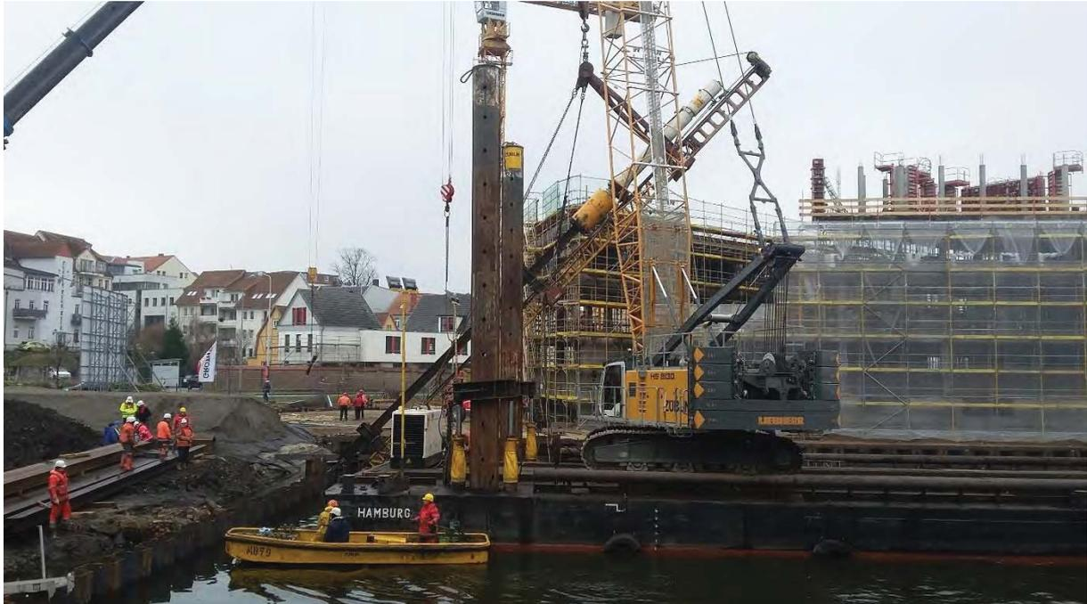
Stelzenponton MC 51 bei der Schrägpfahlrammung
