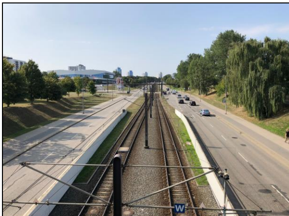
Abbildung 9: Blick südlich auf Südring und Straßenbahn (Vor Ort Begehung 23.08.2018)
