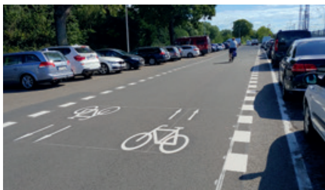
Bild 14: Zu Senkrechtparkständen (im Bild links) sowie Schrägparkern ist ein Sicherheitstrennstreifen von 1,00 m oder mehr vorzusehen. (Foto: ©Tim Birkholz/AGFK MV)
