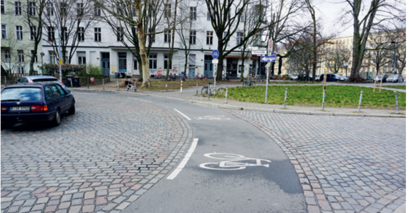
Bild 30: In dieser Einbahnstraße mit Kopfsteinpflaster wurde die Fahrspur für Radfahrende asphaltiert und damit der Fahrkomfort spürbar verbessert. (Foto: ©Thiemo Graf/Innovative Städte)
