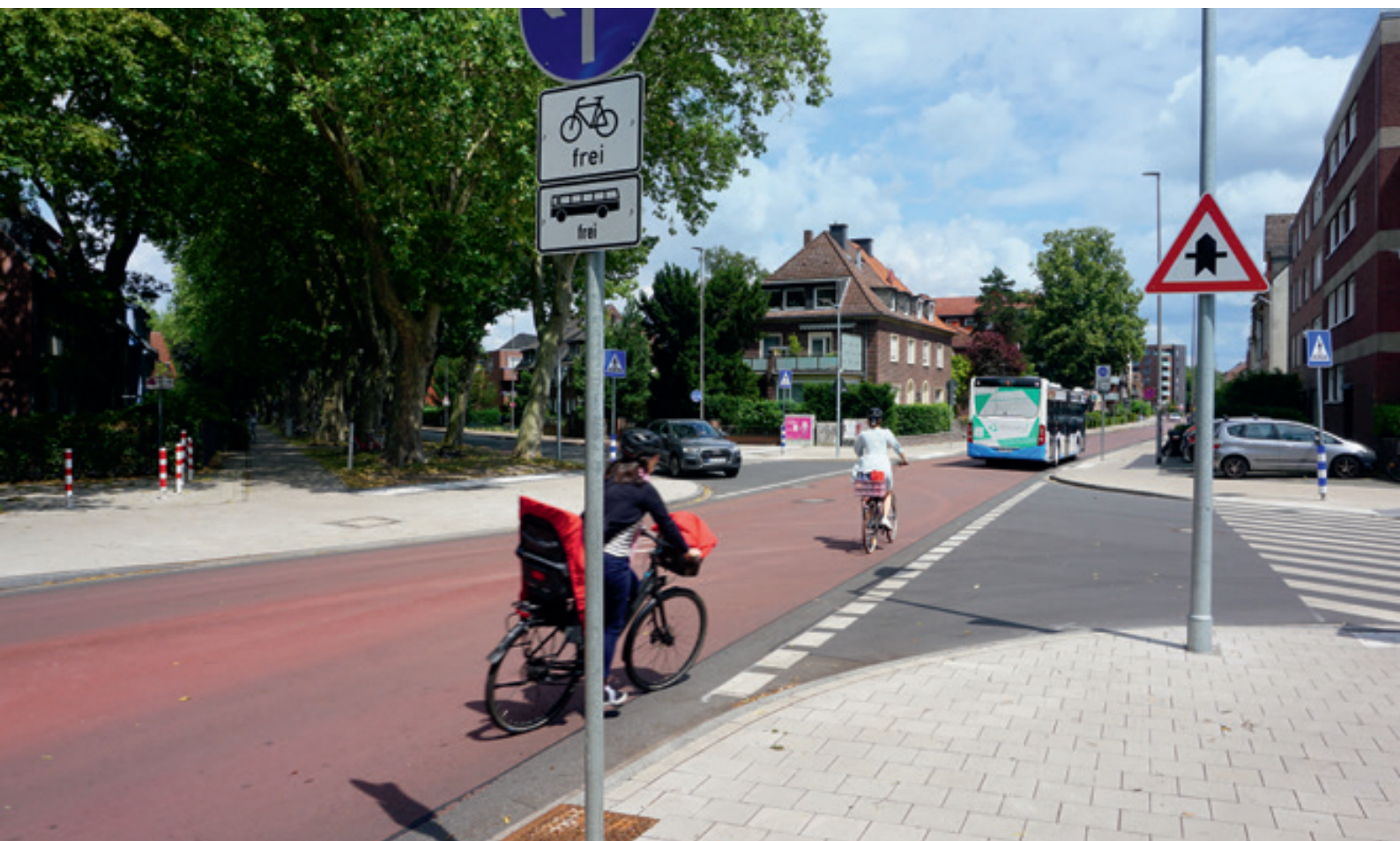
Bild 15: Diese Fahrradstraße mit durchgehender Roteinfärbung der Fahrgasse wurde durch Verkehrszeichen bevorrechtigt. Eine Roteinfärbung ist mindestens an den Knotenpunkten vorzunehmen. (Foto: ©Thiemo Graf/Innovative Städte)
