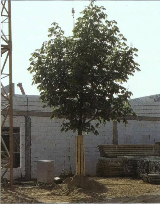
*Abbildung 9: Dieses Bild ist typisch für Baustellen: Wegen der meist vorhandenen Enge wird auch der Wurzelbereich der Bäume für Aufschüttungen oder Materiallagerungen genutzt. Der Stammschutz erfüllt eher eine „Alibi-Funktion“.*
