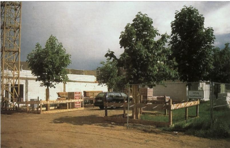
*Abbildung 10: Derselbe Baum nach Beräumung und Errichtung eines Schutzzauns.*
