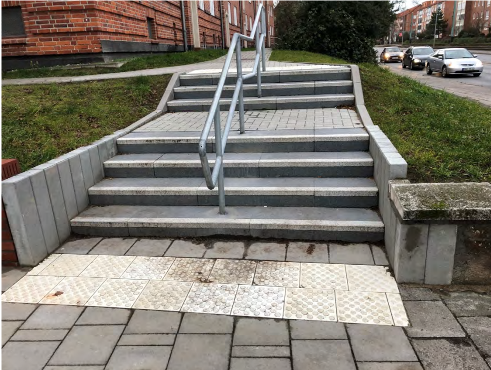
Treppe mit taktilen Elementen und Kontrast an der Stufenvorderkante (neue DIN Noppenfeld unten mit 60 cm Abstand)
