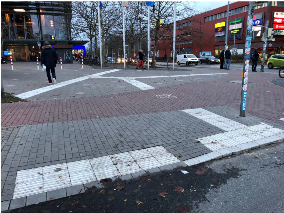
Abfangen einer Fußgängerzone zur Querung Knotenpunkt
