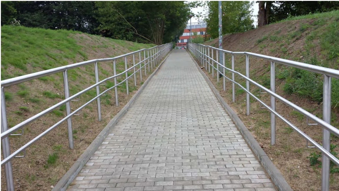
Rampe mit Tasteleiste (Kantenstein) und zwei Handläufen (Erwachsene und Kinder) Die Podeste sind hier schlecht zu erkennen. Hier sollte die Befestigung oder mind. der Kantenstein andersfarbig sein.
