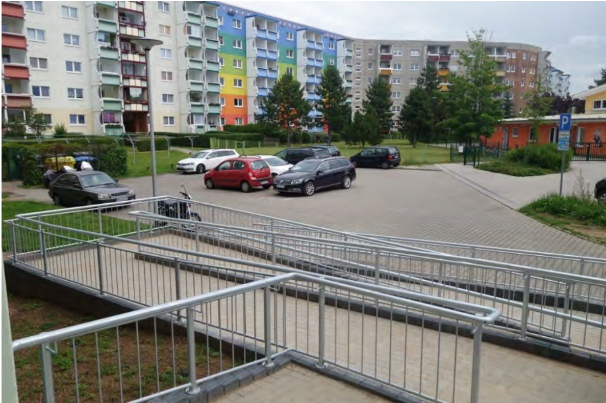
Rampe mit Handlauf
