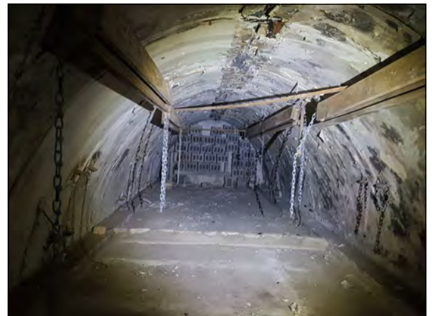
Abb. 46: Fledermausbunker vor der Optimierung
