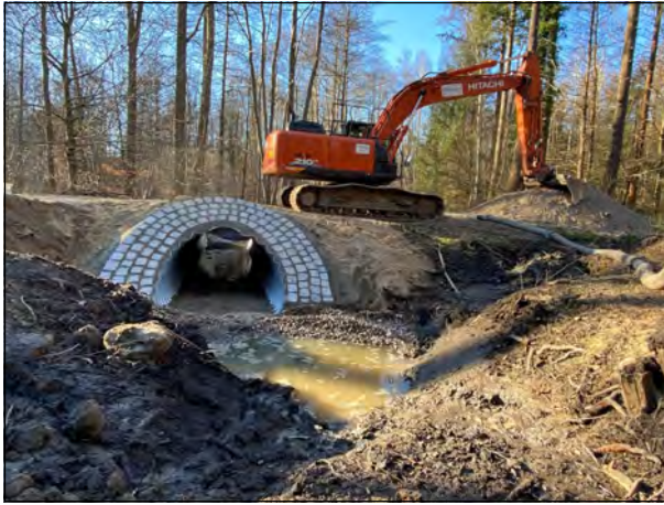
Abb. 43: Renaturierung Radelbach: Durchlass Backofenschneise
