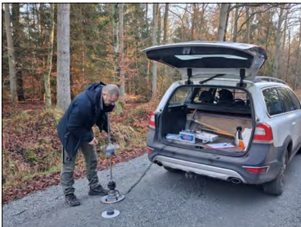
Abb. 60: Qualitätsprüfung bei Abnahme Wegebau
