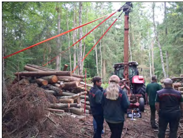
Abb. 26: Holzbringung auf Nassestandort mit Seilkran
