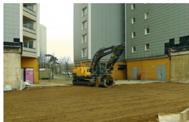
Nach dem Abriss: Der Boden wird planiert, März 2014, Foto: Martin Schönfeld
