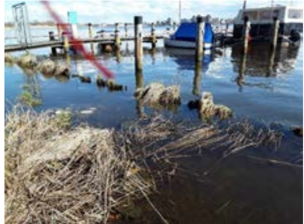
Wellenweg Abb. 4: Abschnitt mit Uferbefestigung (Holzpfähle)
