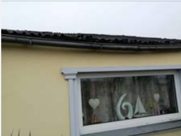
Abbildung 33: Gebäude 15 (Detail Dach 1)
