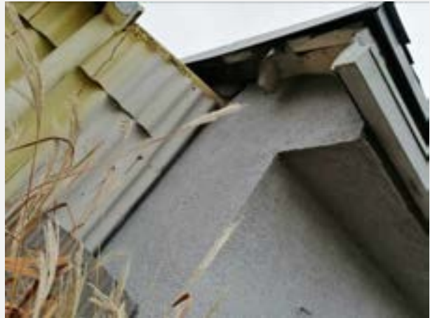
Abbildung 41: Gebäude 19 (Detail Dach)
