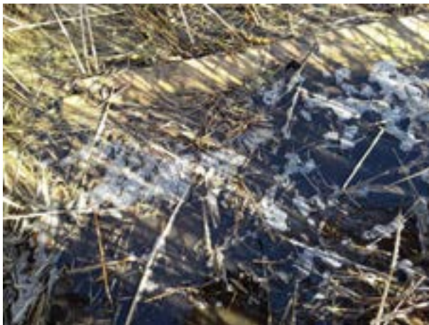
Neuer Steg Abb. 1: flacher Uferbereich mit Betonplatten und kleiner Schilffläche
