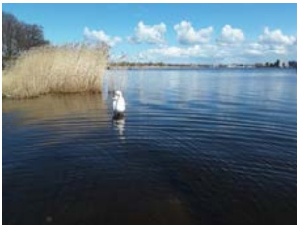
Wellenweg Abb. 1: flacher Uferbereich mit Betonplatten und kleiner Schilffläche
