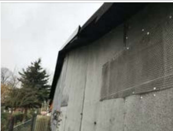
Abbildung 32: Gebäude 14 (Pappverschalung)
