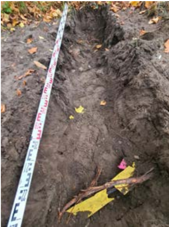
Abbildung 18: Fährberg, D-18147 Rostock. Wurzelforschung westlich am Stammfuß des Baumes an Baumnummer 18 im Grünstreifen. Deutlich verringerte Wurzelanteile durch ursprüngliche Erdarbeiten mit dem Fund bestehender Leitungen. (BECKER, M., 09. NOVEMBER 2020).
