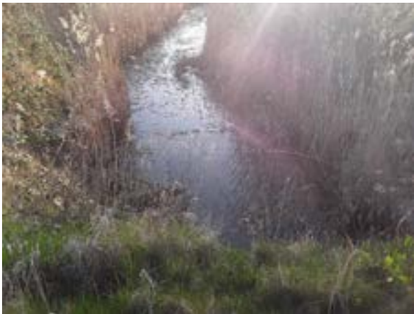
Zingelgraben Abb. 1: befestigter Grabenauslauf unterhalb des Wegedurchlasses
