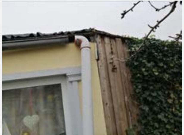
Abbildung 34: Gebäude 15 (Detail Dach 2)
