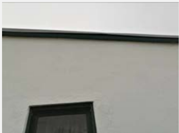
Abbildung 23: Gebäude 9 (Detail Dachblech)
