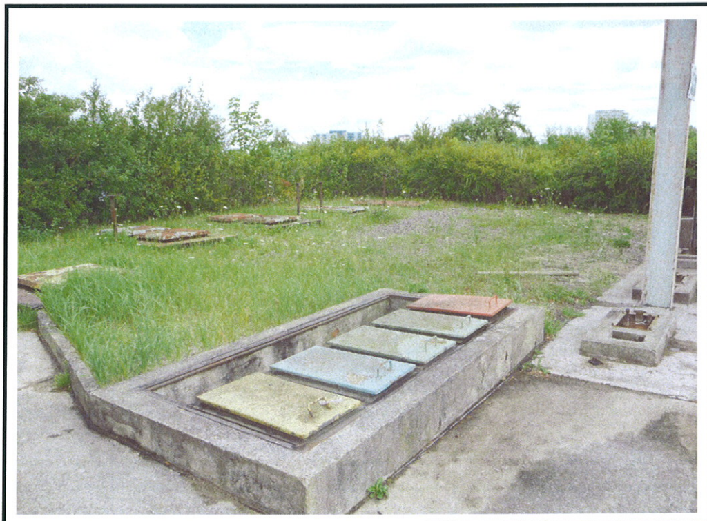
Abb. 2 - ehem. Tankstelle Feuerwache I, Erich-Schlesinger-Straße in Rostock mit 5 unterirdischen Tanks
