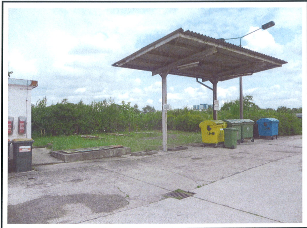
Abb. 1 - ehem. Tankstelle Feuerwache I, Erich-Schlesinger-Straße in Rostock mit 5 unterirdischen Tanks
