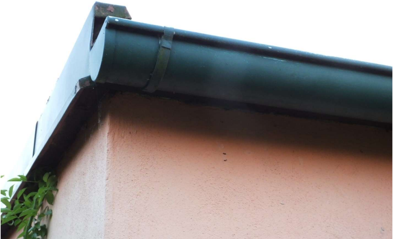
Abbildung 8: Quartierverdacht mit Kotspuren (Foto: IfAÖ)
