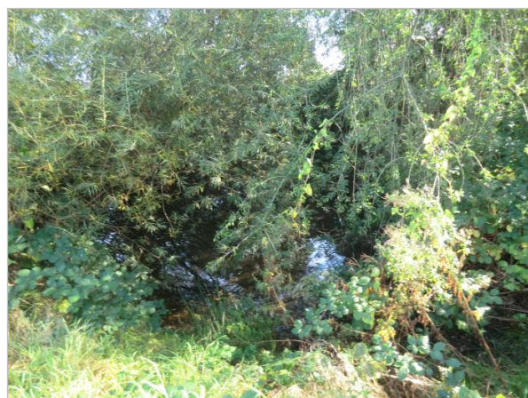
Regenrückhaltebecken, stark bewachsen
