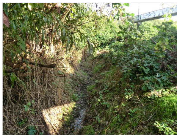
Graben zwischen Auslauf aus Rohrleitung (bei Bahnstrecke) und Schacht (in Hintergrund zu erkennen)
