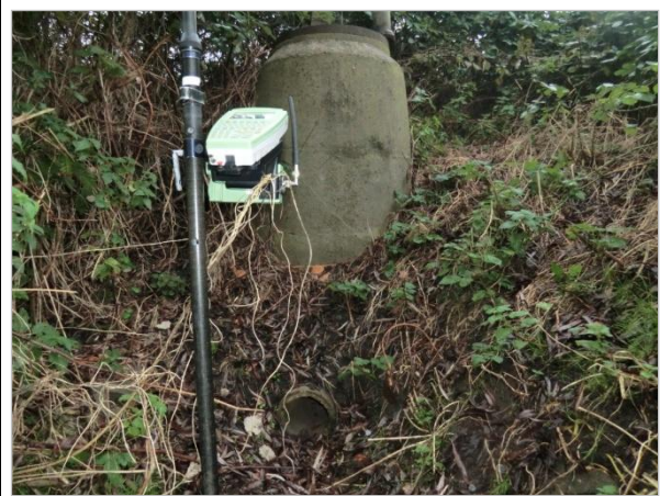
Schacht bei Bahnschienen, Leitung DN200 führt in den unteren Schachtteil
