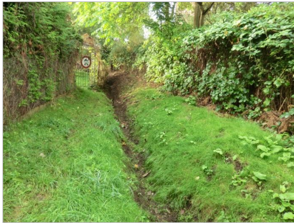
Graben in der Kleingartenanlage „Groter Pohl“
