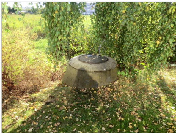
Unbekannter Schacht auf Freifläche südöstlich der Feuerwache
