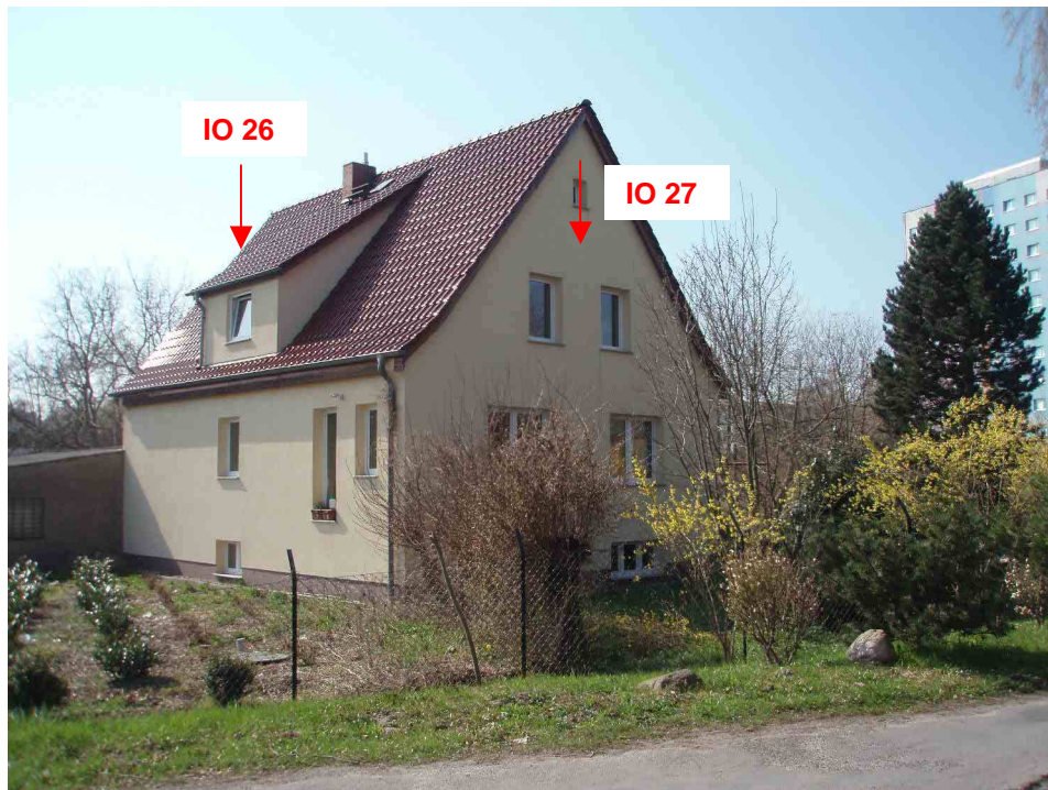
Foto 1: Wohnhaus E.-Schlesinger-Str. 22, Nordwest-Fassade (IO27)
