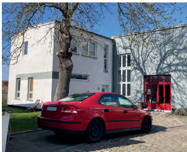
Abb. 49: PI 13 Culttourhalle, Quelle: Sweco GmbH
