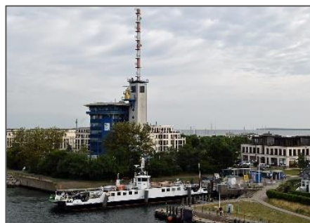
Abb. 51: Lotsenstation am Fähranleger Hohe Düne. Quelle: Dahlstrøm Nielsen (2021).
