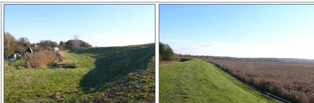
Abb. 37: links: Ansicht der Hochwasserschutzanlage – Innenseitig KGA Erlengrund; rechts: Ansicht der Hochwasserschutzanlage, außenseitig mit Blick ins Radelseer Moor. Aufnahmen: BSR (2021).
