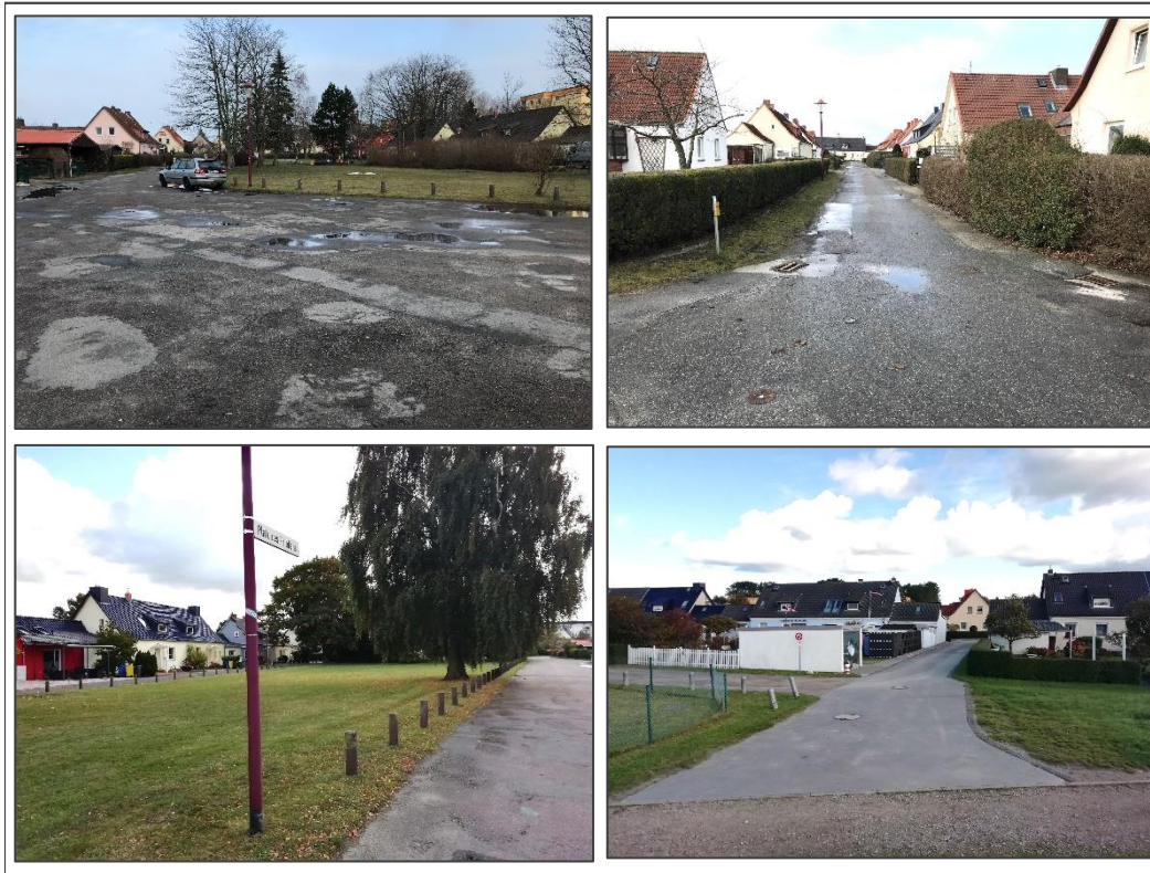
Abb. 107: Von links oben nach rechts unten: Foto 1: Siedlerhäuser am Platz des Friedens; Foto 2: Bebauungsstruktur Neptunweg; Foto 3: Siedlungsanger Platz des Friedens; Foto 4: Blick in den Weg der Freundschaft. Aufnahmen: BSR (2022).
