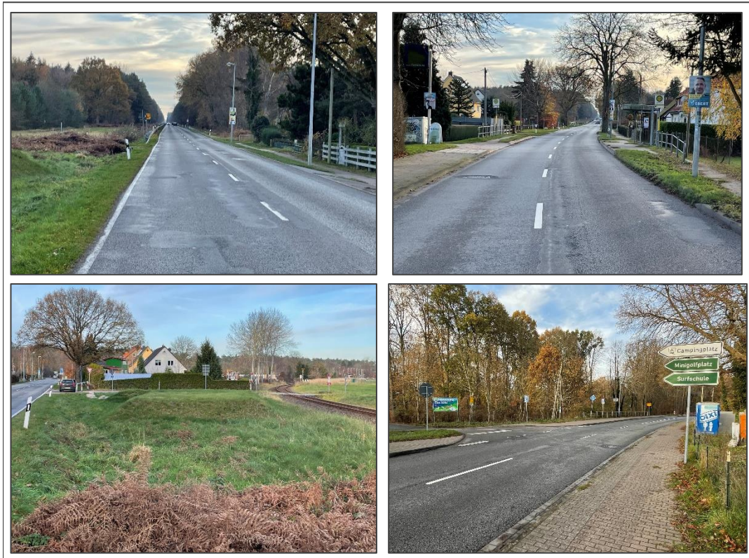
Abb. 79: Von links oben nach rechts unten: Foto 1: kaum wahrnehmbarer südlicher Ortseingang bzw. -ausgang; Fotos 2: Zugang zum DB-Haltepunkt (links), beidseitige Bushaltestellen jedoch ohne Sitzgelegenheit und ohne Querungshilfen; Fotos 3: ungestaltete Freifläche am südlichen Ortseingang; Foto 4: Abzweig zum Campingplatz und Waldparkplatz in Torfbrücke. Aufnahmen: BSR (2022).
