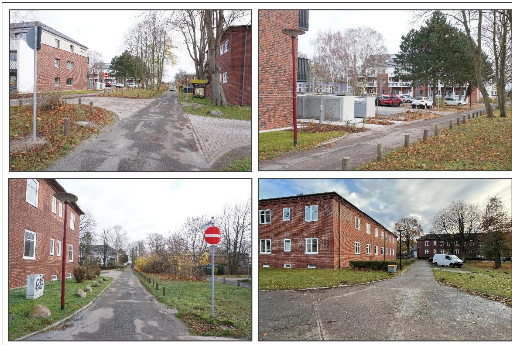
Abb. 106: Von links oben nach rechts unten: Foto 1: Ersatzwohnungsbau A.-Köbis-Str. 8 (links) und Altbau A.-Köbis-Str. 7 (rechts); Foto 2: Blick auf A.-Köbis-Str. 10; Foto 3: A.-Köbis-Str. Altbauten Hausnr. 5 (links), Hausnr. 6 (rechts, inzwischen durch Neubau ersetzt); Foto 4: Gebäude Albin-Köbis-Str.- West. Aufnahmen: BSR (2022).
