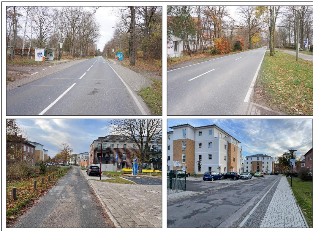
Abb. 91: Von links oben nach rechts oben: Foto 1: Ortseingangsbereich Ost/Schulzenwiese; Foto 2: östlicher Abschnitt der innerörtlichen Warnemünder Straße ohne Querungshilfe und nördlichem Fuß- und/oder Radweg; Foto 3: alte Wohnstraße Albin-Köbis-Str. verliert an Qualität durch Neubau von Stellplätzen, versiegelte Zufahrtsbereiche etc. im Ortszentrum; Foto 4: versiegelter unattraktiver Straßenraum für ruhenden und fließenden Verkehr. Aufnahmen: BSR (2022).
