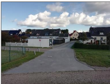
Abb. 49: Siedlungsbau in Hohe Düne am Neptunweg. Aufnahme: BSR (2021).
