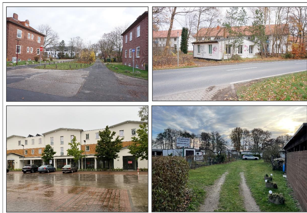
Abb. 69: Von links oben nach rechts unten: Foto 1: östlicher Abschnitt der Albin-Köbis-Straße links Hausnr. 6a (links, hier steht bereits ein Ersatzwohnungsneubau der WIRO), rechts Hausnr. 7a; Foto 2: zwischengenutztes altes Gebäude Warnemünder Str. 14, im Hintergrund BIMA-Wohnungsbau an der Max-Reichpietsch-Str.; Fotos: 3 Neubauten im Ortskern kurz nach Fertigstellung; Foto 4: KGA Erlengrund südl. Albin-Köbis-Str. Aufnahmen: BSR (2021/2022).
