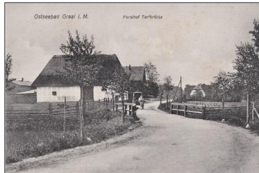
Abb. 60: Torfbrücke 1930, von Graal Müritz kommend, Höhe Stromgraben. Quelle: Ortschroniken Mecklenburg-Vorpommern/Windfluechtermv (2019).
