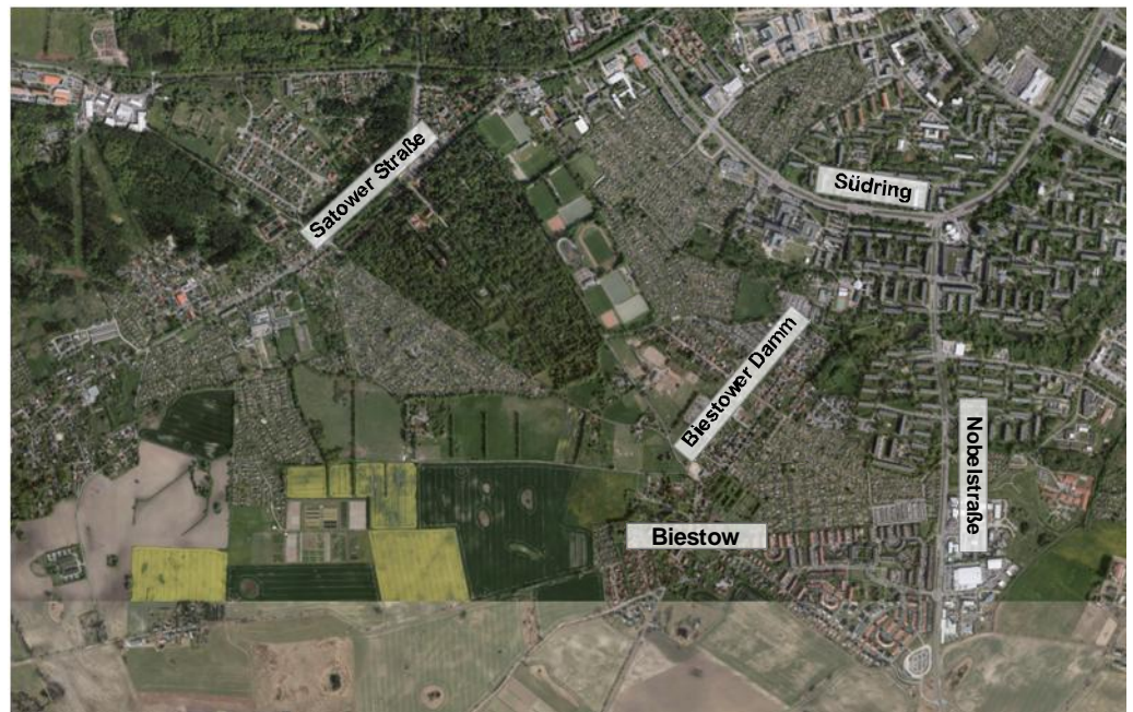
Abb. 1 Luftbild des Untersuchungsgebietes (Quelle: Hansestadt Rostock; Ergänzung: SHP Ingenieure)
