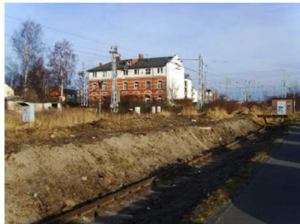
Ehem. Bahngebäude im Plangebiet
