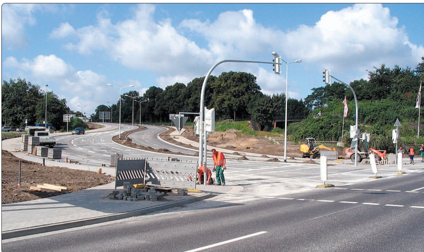
Die neue Verbindungsstraße Am Kanonsberg: Schneller in die City. Pünktlich zur Hanse Sail rollt der Verkehr zwischen Warnowufer und Innenstadt. Die Verkehrsübergabe ist am 3. August geplant.
