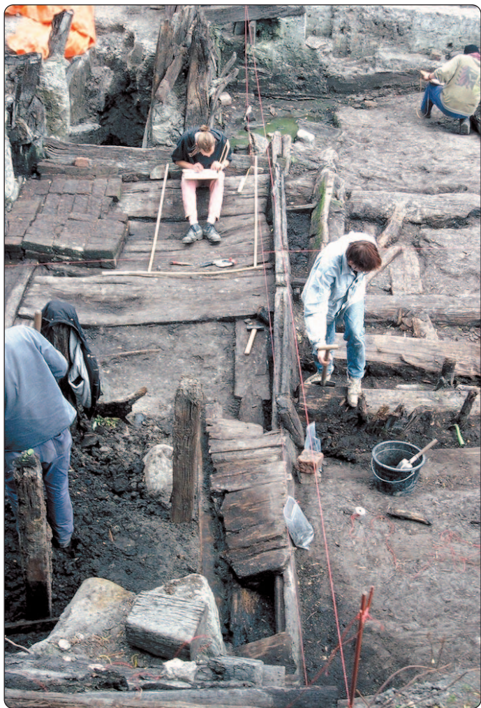
Ausgrabungen in der Grubenstraße 1996
