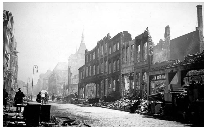
Zerstörte Langen Straße aus den ersten Maitagen 1942.
