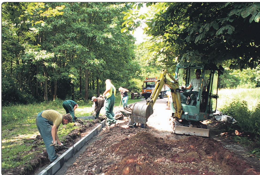
Arbeiten im Fischerdorf im Stadtteil Lütten Klein.
