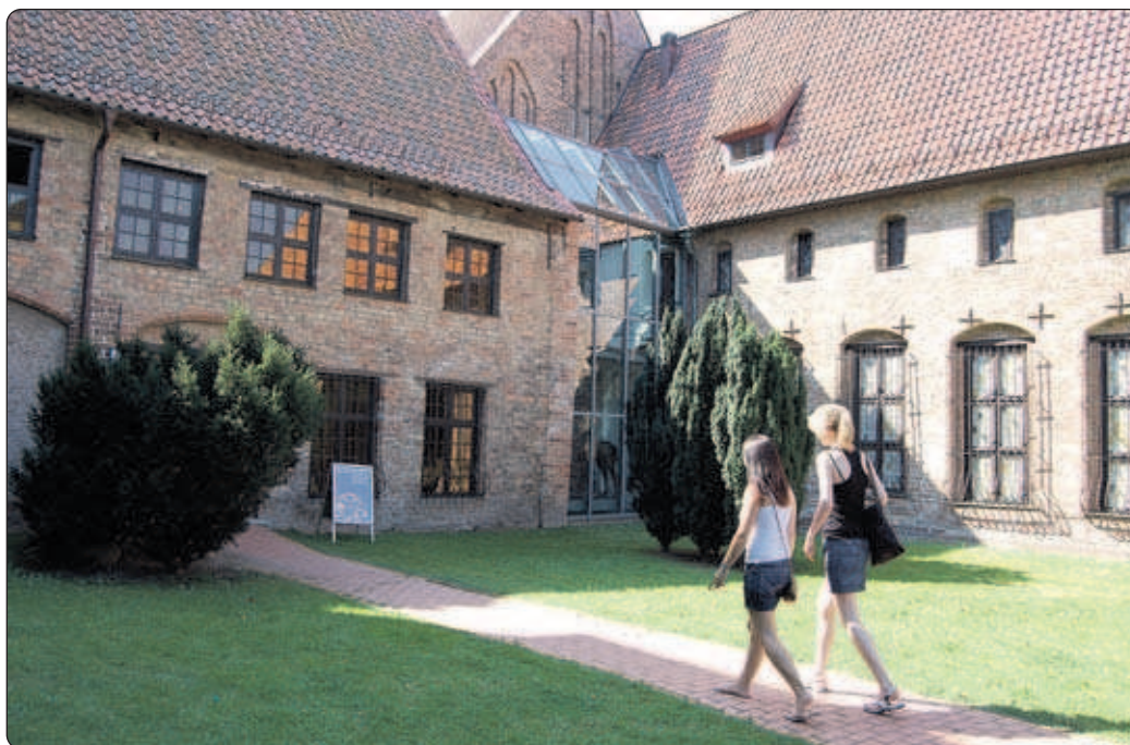
Auch das Kloster zum Heiligen Kreuz lädt am Tag des offenen Denkmals zu Veranstaltungen ein. Hier ein Blick auf den derzeitigen Eingang an der Nordseite des Klosters während der Sanierung.
