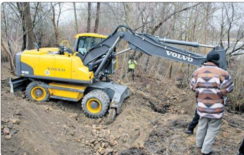
Die Grabungsarbeiten am Mühlendamm konnten erst beginnen, nachdem die frostige Witterung nachgelassen hatte. Foto: Robert Stach
