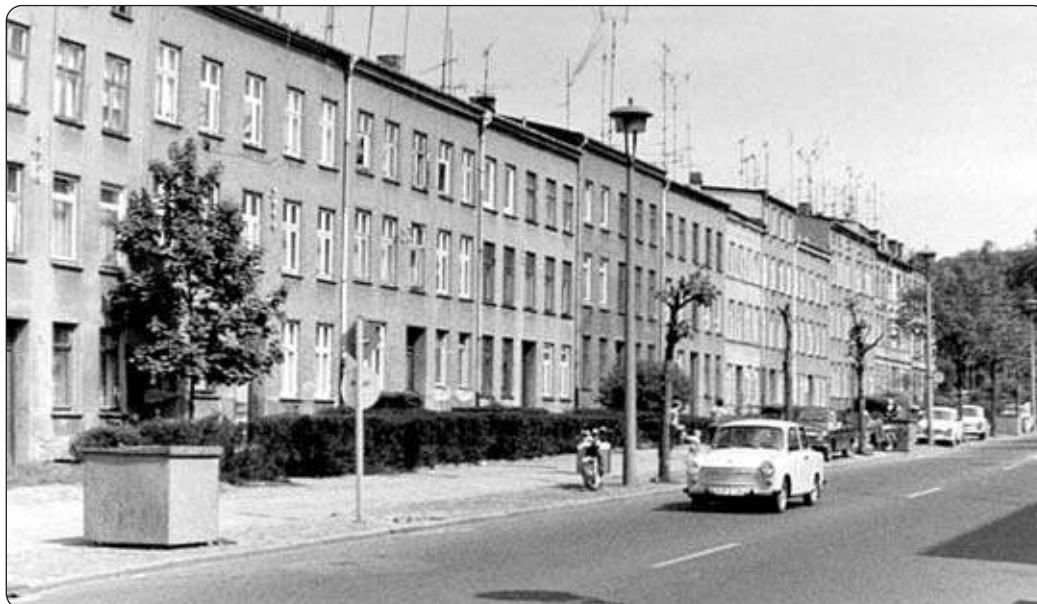
Ein Blick in die Vergangenheit. So präsentierte sich die Ulmenstraße im Jahr 1985.
