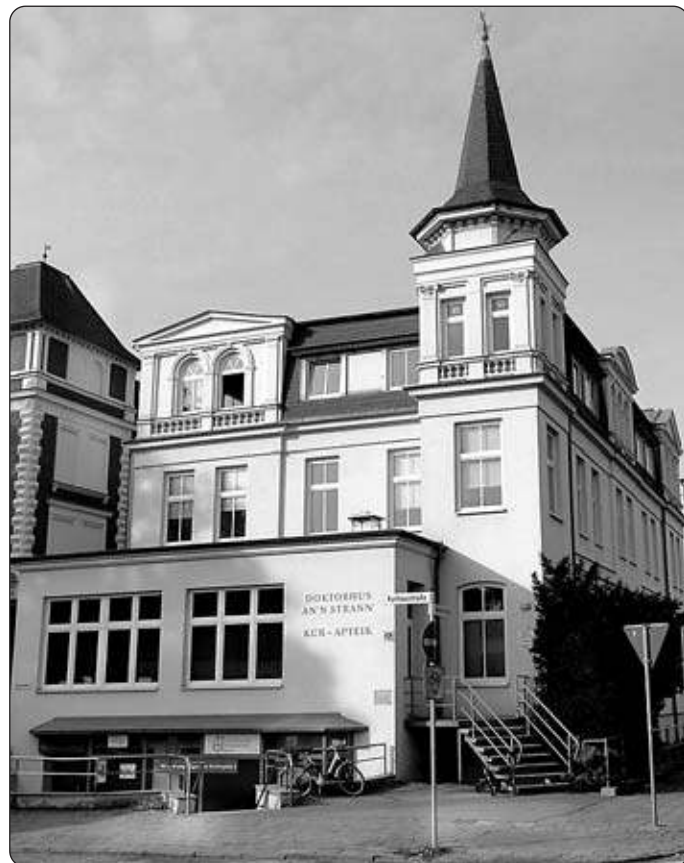
Gebäude Kurhausstraße 1 - Vorderansicht
