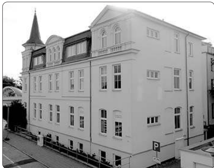
Gebäude Kurhausstraße 1 - Rückansicht
