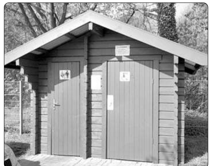
Die von der schwedischen Firma DANFO hergestellten Rostocker Blockhaustoiletten gelten in Skandinavien als sehr gängiges Toilettenmodell.
