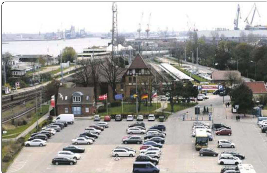
Erforderliche Stellplätze sollen zukünftig im südöstlichen Teil der Mittelmole in Form von Parkhäusern und Parkplätzen untergebracht werden. Foto: Thorsten Hortig
