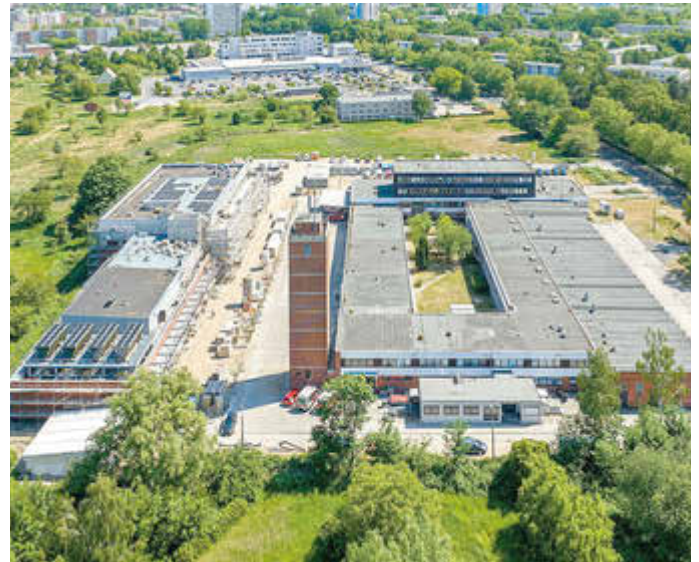
Die Feuerwache 1 in der Rostocker Südstadt wird in mehreren Bauabschnitten zu einem Zentrum für Brandschutz, Rettungsdienst und Katastrophenschutz umgebaut.
