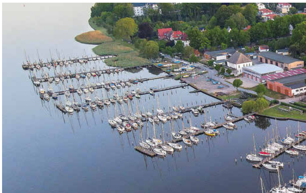
Die Sanierung der Uferkante beginnt Höhe Gehlsheimer Straße.
