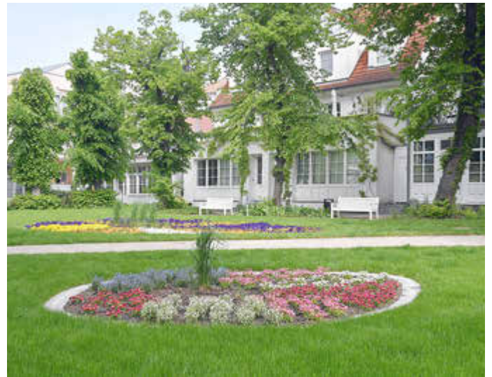
Blick auf den sanierten Georginenplatz. Foto: Joachim Klock
