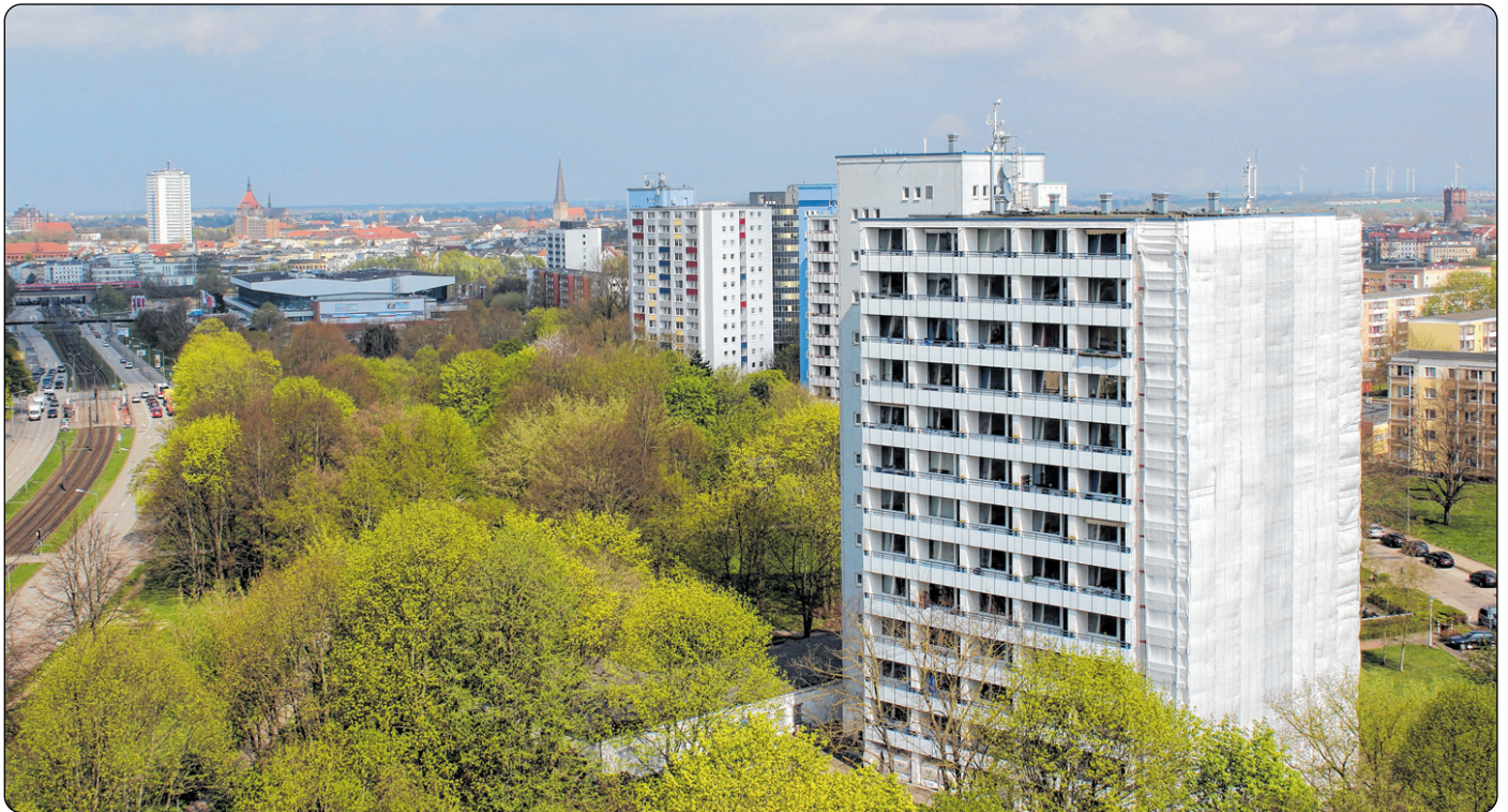
Die Südstadt war Rostocks erste einheitliche Großwohnsiedlung in Plattenbauweise und entstand in den Jahren 1961 bis 1965.
