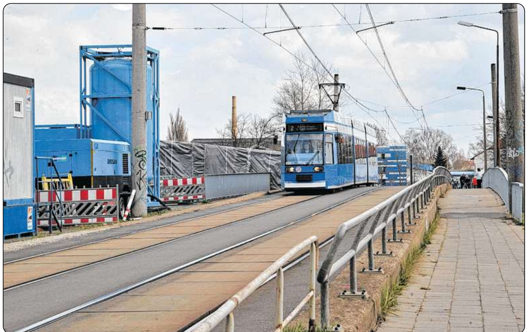
Bauarbeiten an der Petribrücke haben begonnen. Der Straßenbahnverkehr ist ab 16. März betroffen.
