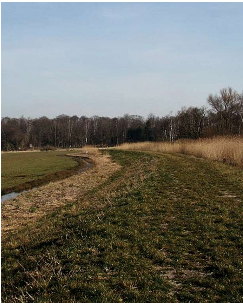
Einsatz im Deichbau
