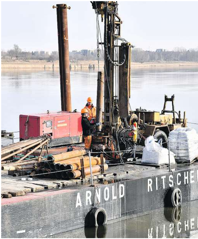
Für den vorgesehenen Brückenneubau über die Warnow wird zur Zeit der Baugrund erkundet.
