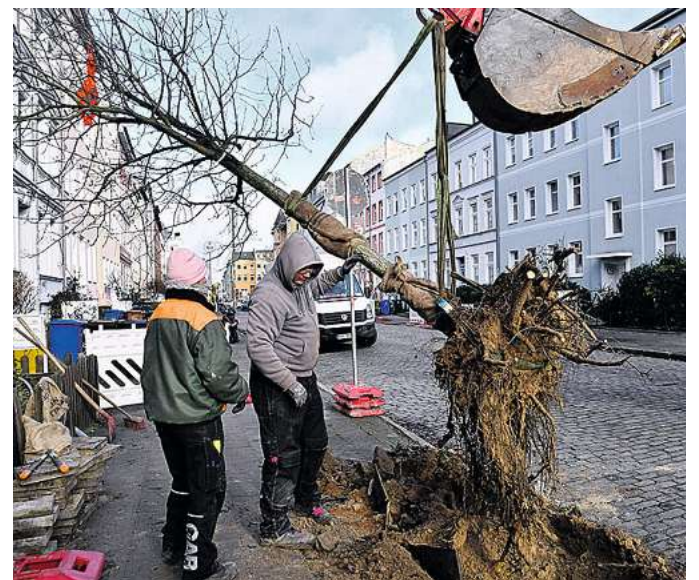
Über das Projekt informierte das Amt für Stadtgrün, Naturschutz und Friedhofswesen interessierte Einwohnerinnen und Einwohner. Die Fritz-Reuter-Straße wird in drei Bauabschnitten saniert. Begonnen wird im Frühjahr mit dem Abschnitt zwischen Doberaner Straße und Borwinstraße. Neue Leitungen für Trink- und Abwasser sowie ein Regenwasserkanal sind geplant. Fotos (2): Joachim Kloock
