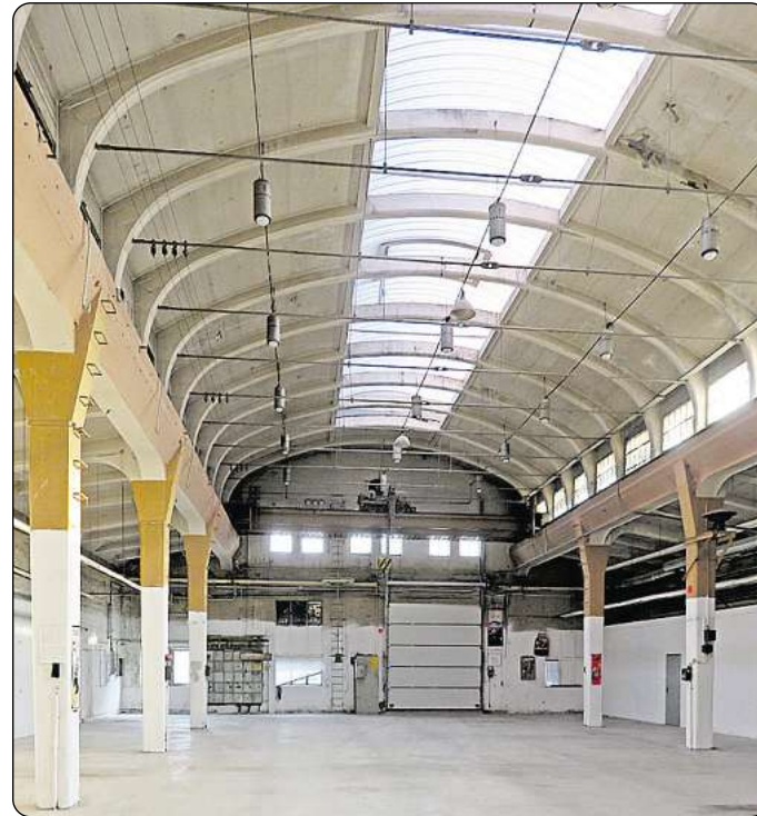
Blick in die Halle auf dem ehemaligen DMR-Gelände.
