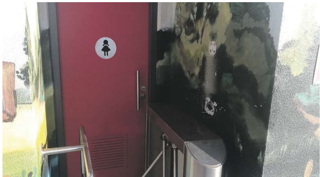
Vandalismus sorgt alljährlich für Schäden von tausenden Euro. Hier wurde ein Münzautomat aus der Verankerung gerissen. Foto: Axel Pohl
