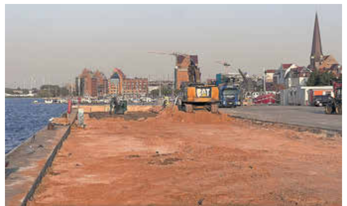
Die Arbeiten auf der Christinenhalbinsel sollen bis zur Hanse Sail 2025 abgeschlossen sein. Foto: Josefine Rosse
