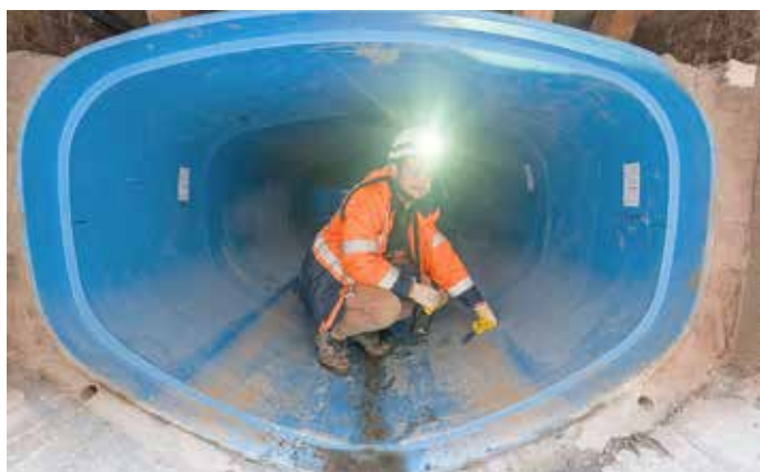
Blick in den bereits sanierten Teil des Altkanals in der Werftstraße. Foto: Martin Börner
