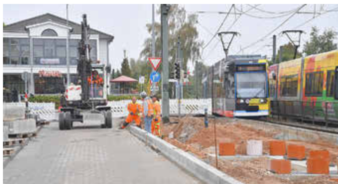
Blick auf die Bauarbeiten
