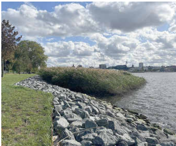
Erneuerung der Ufersicherung in Gehlsdorf Foto: Christine Zilse
