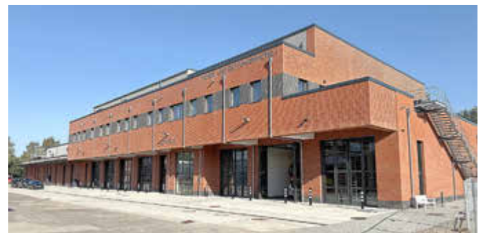
Blick auf den Erweiterungsbaus.
