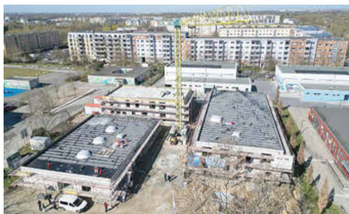
Die Rohbauarbeiten für den Gebäudekomplex in der Pablo-Neruda-Straße sind abgeschlossen.
