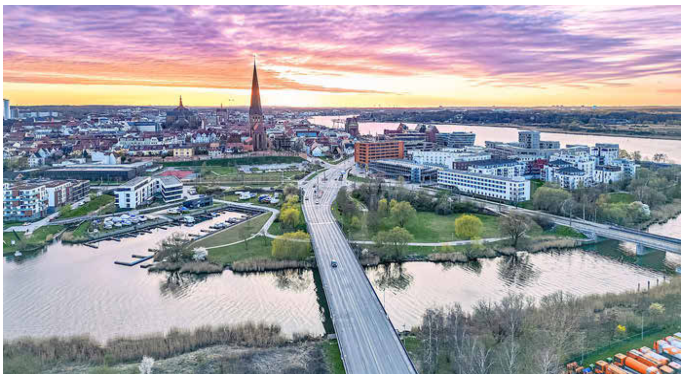
Die Vorpommernbrücke ist eine bedeutende Wegeverbindung in Rostock. Perspektivisch muss ein Ersatzneubau her.
