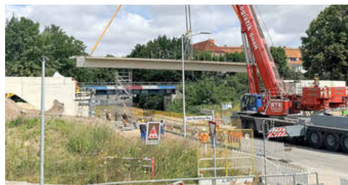
Ein Schwerlastkran verhebt die 26 Meter langen Träger. Foto: J. Rosse
