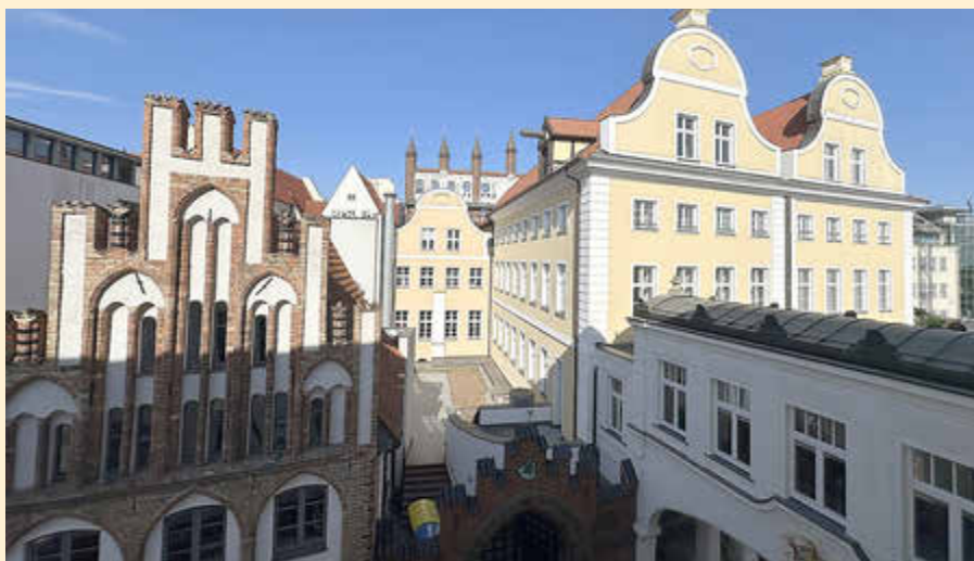
Rathaus von hinten: Gut erkennbar sind die drei einzelnen Gebäude, die auf der Marktseite mit einer gemeinsamen Schauwand verkleidet wurden.
