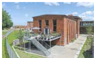
Ehemaliges Trafogebäude im Fischereihafen Marienehe
