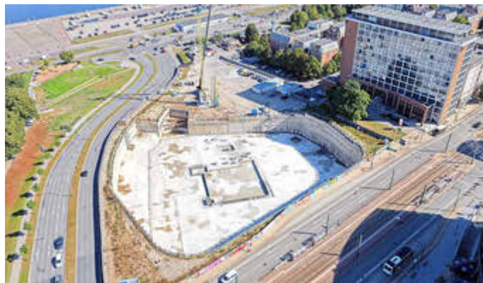
Blick in die Baugrube im August.
