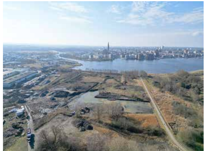
Hier entsteht das WarnowQuartier.
