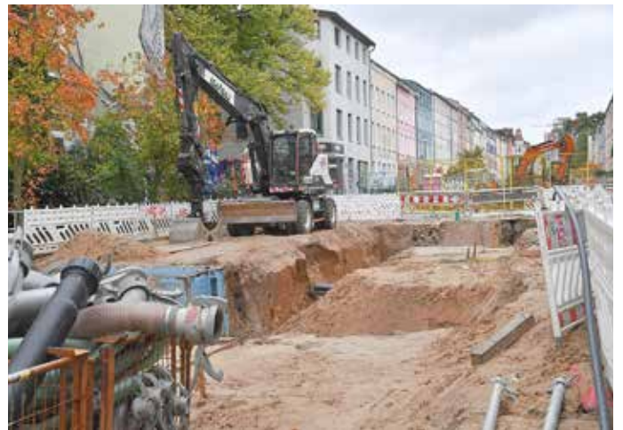
Baustelle in der Fritz-Reuter-Straße.
