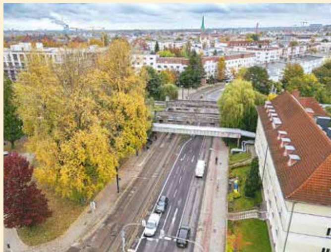
Die Trogbrücke für die Fernwärmeleitung am S-Bahnhof Parkstraße wird saniert. Foto: Josefine Rosse
