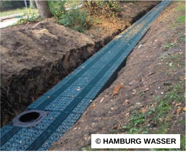
Unterirdische Speicherung, Tiefenbeschickung/Versickerung (Rigolen)
