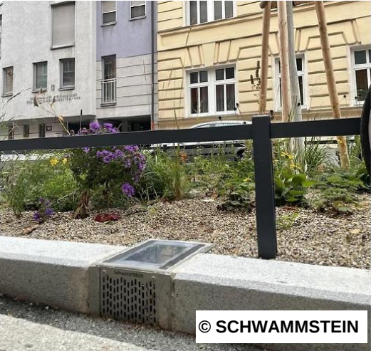
Unterirdische Speicherung, Tiefenbeschickung/Versickerung (Rigolen)
