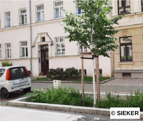
Tiefbeete – Versickerungs- und Verdunstungsmulden
