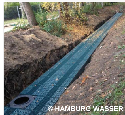
Unterirdische Speicherung, Tiefenbeschickung/Versickerung (Rigolen)
